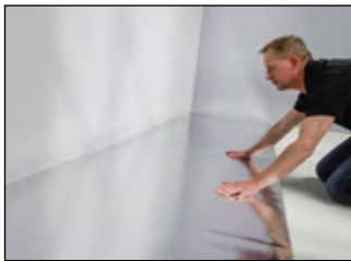
Læg underlaget på det forberedte underlag.
