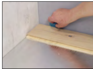
Konstater/Beregn vinklen af læggefladen, og tilpas den første plankerække ved at skære den til.
