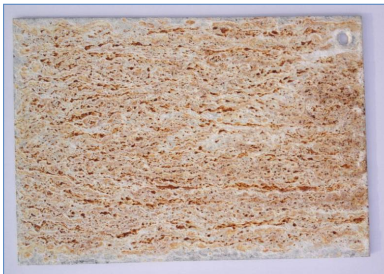
Korrosionsprovning utförda av SP Sveriges Tekniska Forskningsinstitut. Bilden visar utfall av traditionellt förzinkad plåt efter korrosionsprovning enligt ISO 11997-1 metod B under 10 veckor.
