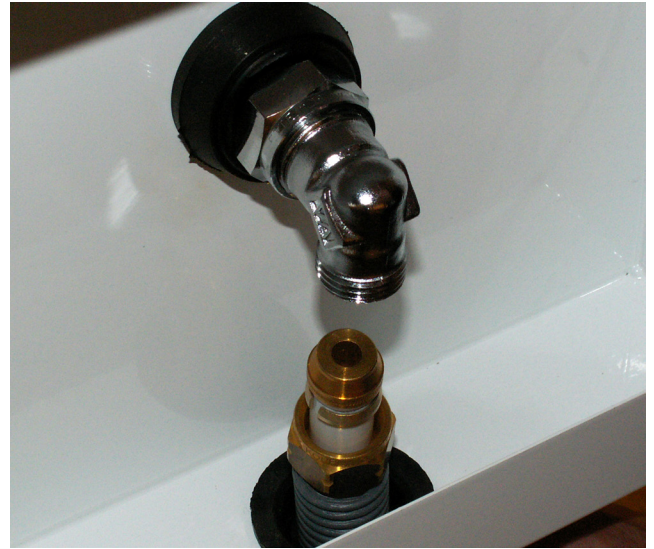
7. LK Universalröret ansluts mot vinkelkopplingen med LK Kopplingsset AX16, RSK 481 43 73.
