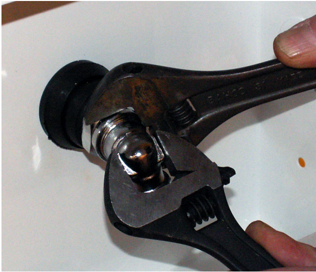
5. Montera vattenutkastarens vinkelkoppling på kopparröret.
