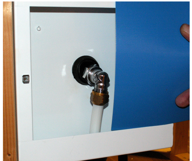
8. Montera de medföljande sprutskydden.
