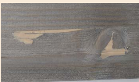
Ytbehandlad med träspackel på doppimpregnerat trä
