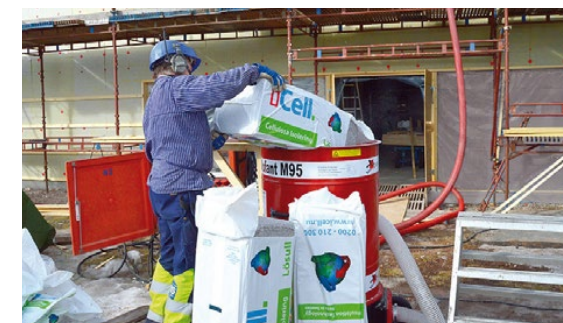
iCell Lösull sparar material då inget spill förekommer, endast exakt mängd material för varje konstruktion installeras, resterna av isoleringen tas om hand och kan användas i nästa byggprojekt.
