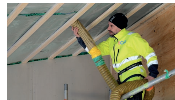
iCell Lösull med sin höga densitet i kombination med hög tröghet isolerar bättre och lufttätheten medför också en utmärkt ljudisolerande förmåga
