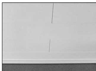
Sæt loftafslutningslisterne på – færdig
