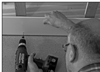
Fastgør det første panel
