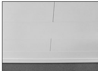
Sæt loftafslutningslisterne på – færdig
