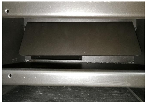
Bild 2: Überprüfen Sie die korrekte Position der Rauchleitplatte.
