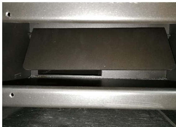
Billede 2: Tjek at røglederpladen sidder korrekt placeret på krogene.
