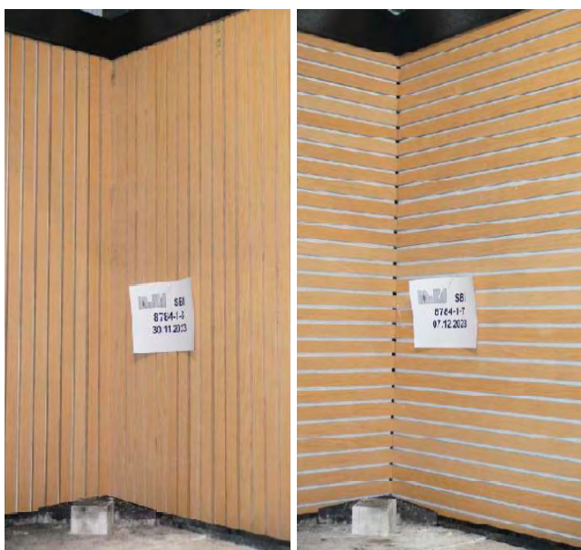
Figur 1: Prøvemontage i SBI – Vertikal og horisontal orientering af lameller.
