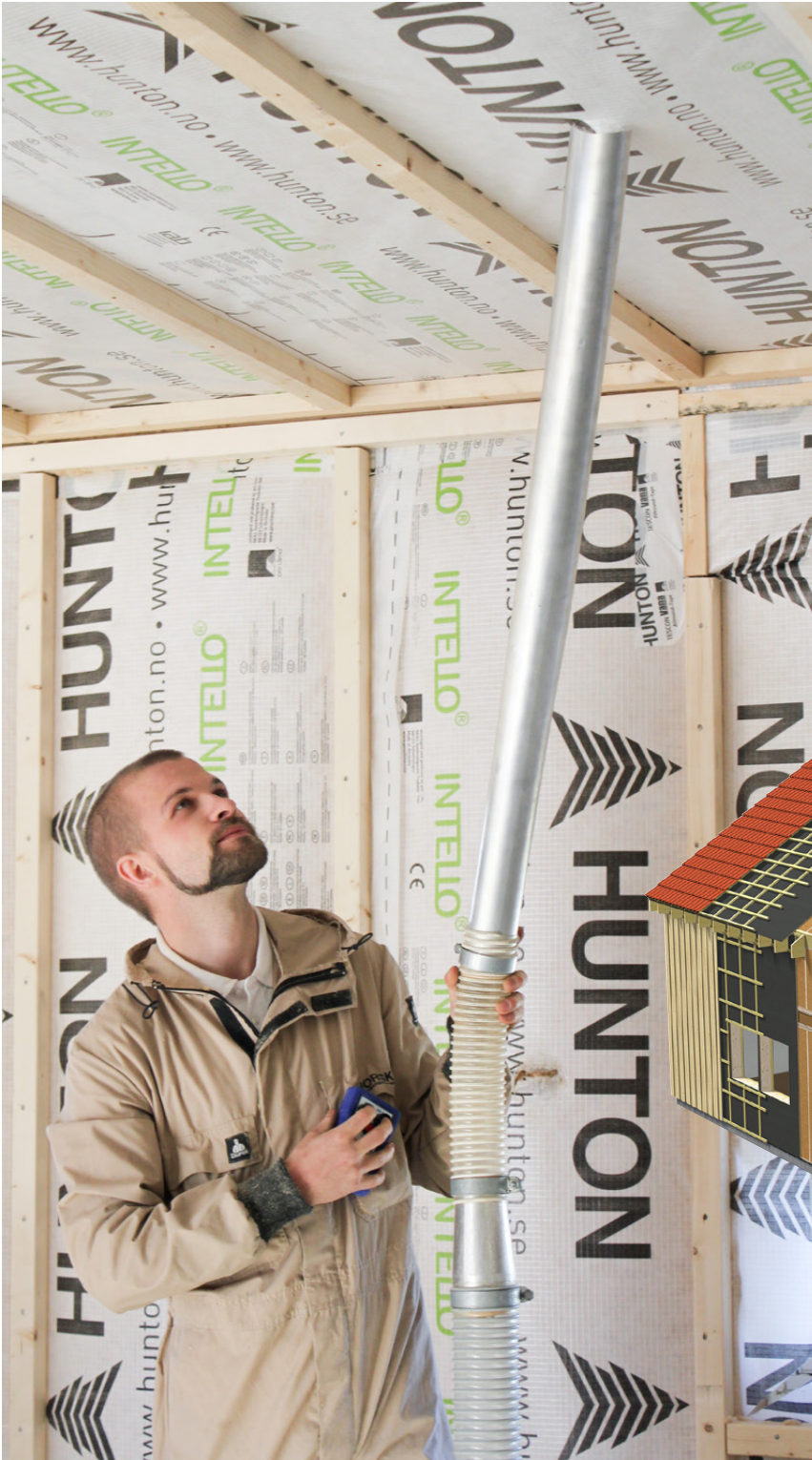
Illustrationen visar vägg blåsisolerad med Nativo Träfiberisolering.
