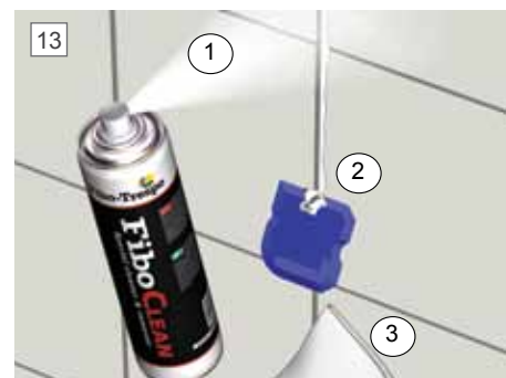
13 NB det skal være så mye fugemasse i skjøten at fugemassen tyter ut i hele skjøtens lengde.
