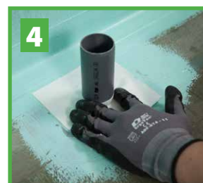
4 Välj manchett efter rörets diameter och tryck fast mot rör och underlag. Täck manchetten med 553 Multiseal Membrane.
