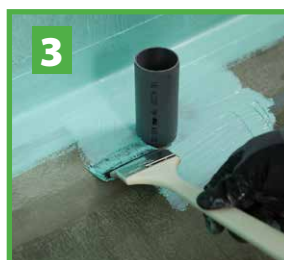
3 Applicera 553 Multiseal Membrane runt avloppsrör.
