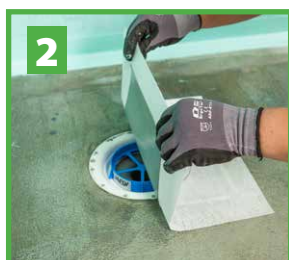
2 Vid golvbrunn monteras självhäftande brunnsmanschett (530). Se sid 14.
