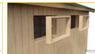
Monter vinduer og dører
