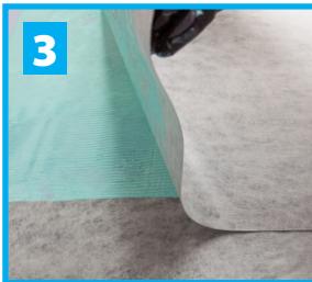
Håll de yttersta 30 mm på båda folierna/våderna fria från membranen (553, 580). Åtgång: Se sid 14.
