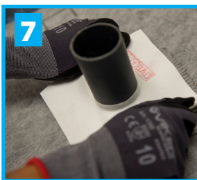
Rörmanschett monteras i 570 Seal Glue ovanpå 550 Waterproofing Mat. Kamma ut lim (570) 15 mm ut på röret innan montering av rörmanschett.
