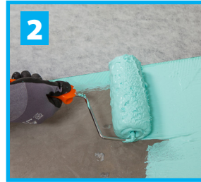
550 Waterproofing Mat monteras med överlapp fortlöpande i den våta 553 Multiseal Membrane/580 2K Membrane. Håll överlappet i golv-vägg-vinkel fritt från membran eller lim.
