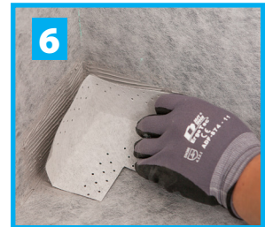
Inner- och ytterhörn monteras i 570 Seal Glue ovanpå 550 Waterproofing Mat. Tryck fast ordentligt så att inga blåsor förekommer.
