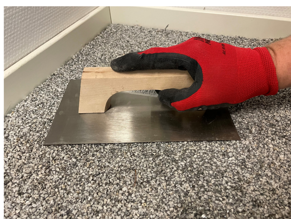
4. Klappa ner stenen med en klappbräda.
